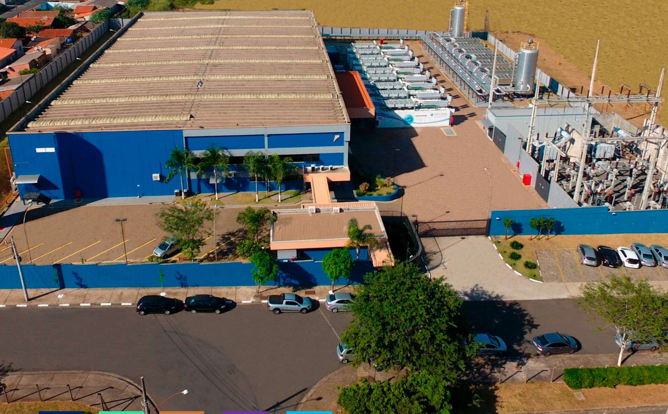
Data Center Hortolândia 1
